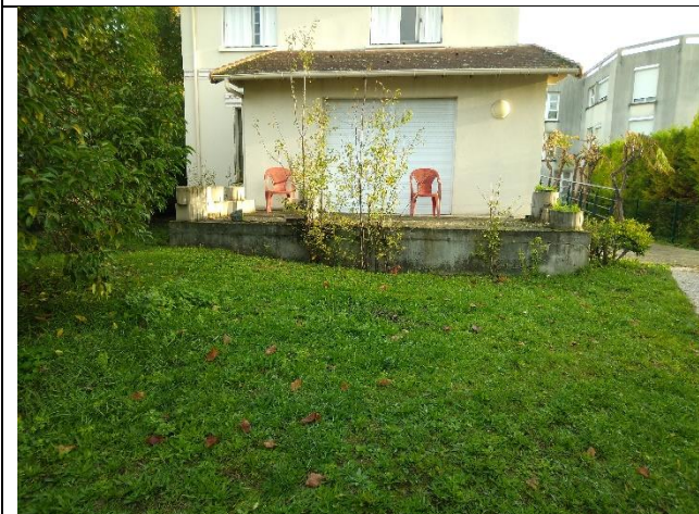
Bâtiment sud-ouest IME
