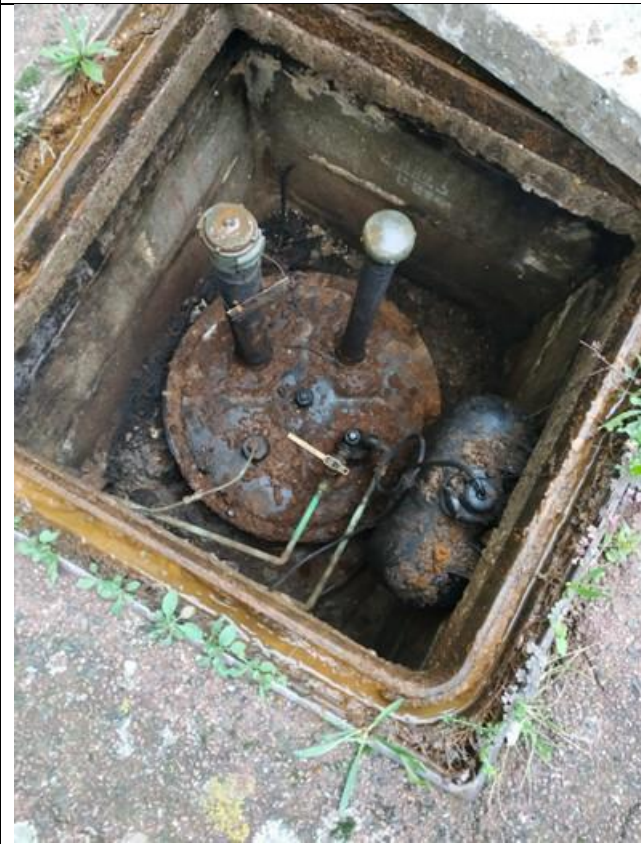
Intérieur cuve enterrée à proximité bâtiment sud-ouest
