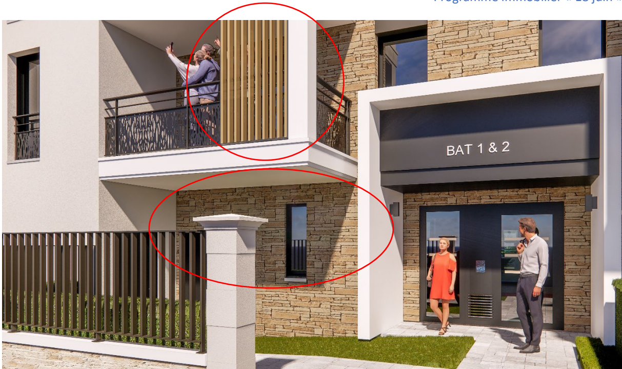
Figure 12 : Exemple de limitation d'apports solaire : claustras bois et balcons sur le bâtiment 1-2
