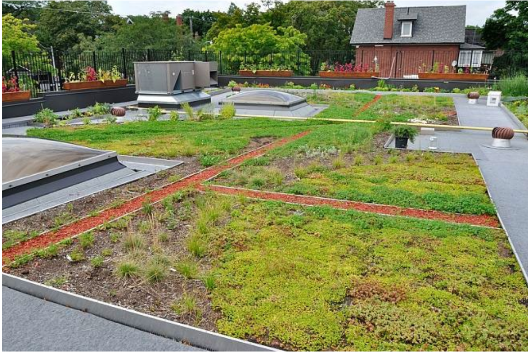
Figure 1 : Exemple de toiture végétalisée
