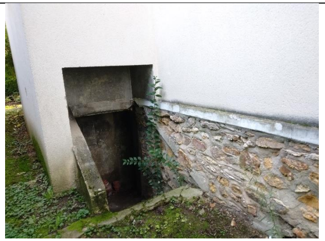
Accès sous-sol des bâtiments au sud-ouest de l'IME
