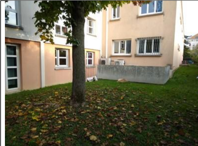
Bâtiment IME partie est – accolé aux pavillons
