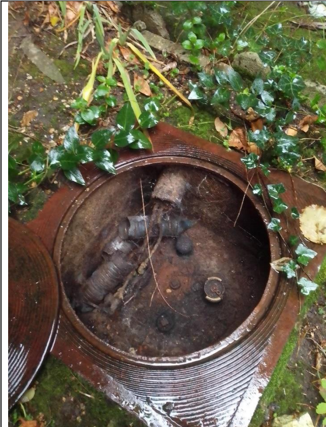
Intérieur cuve enterrée parcelle 220
