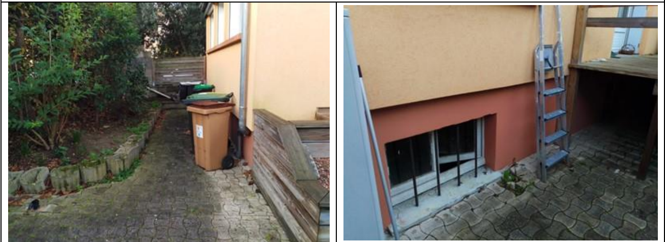
Parcelle 216 – sous-sol total au droit du pavillon
