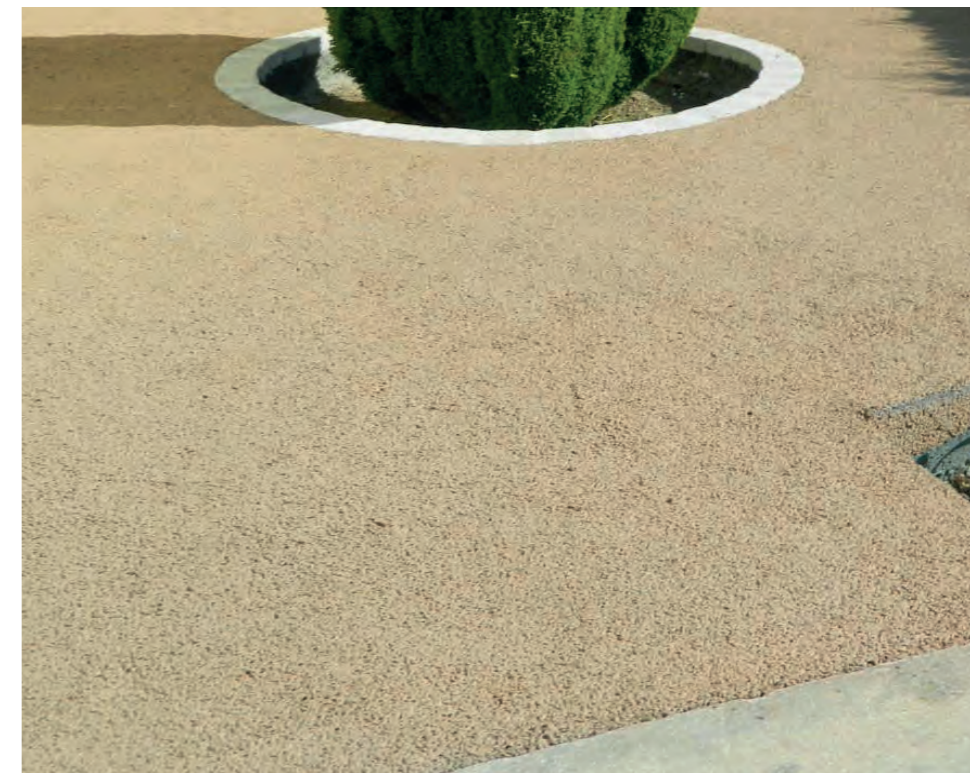
Allées en béton drainant
